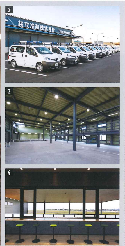
※空調・換気送風機・LED照明は、三菱電機製品を採用 ※1 3 4は竣工写真ご提供
